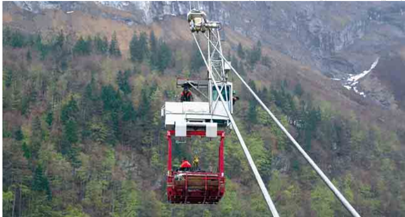
Materialtransport zur Bergstation am neuen Seil
